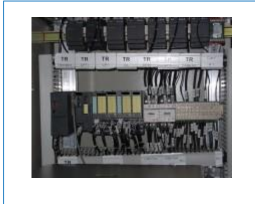
■ Automates situés dans l'armoire DOF1-Sol
